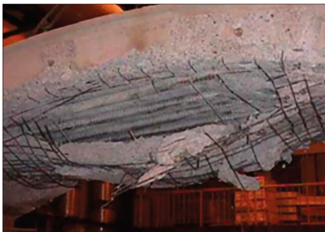
Imagen 20. Spalling
