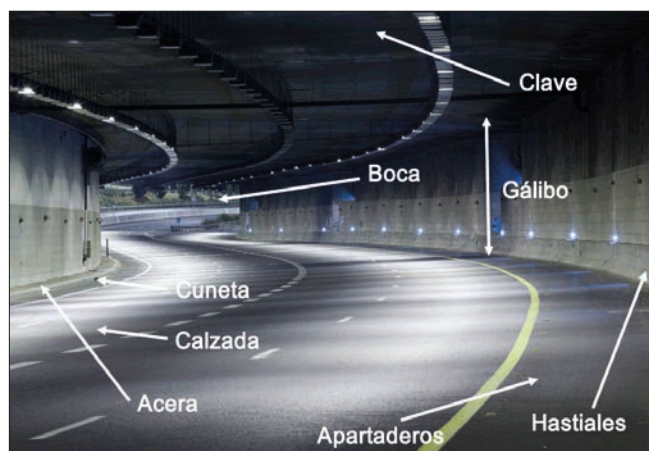
Imagen 1. Partes de un túnel
