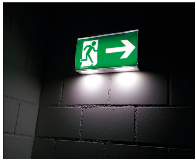
Imagen 11. Salida de emergencia
